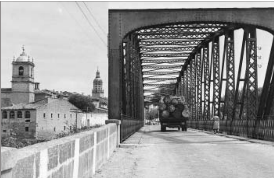
Foto 15. Fotografía del puente metálico a mediados del siglo xx. Construido en 1892, se hundió noventa años después
