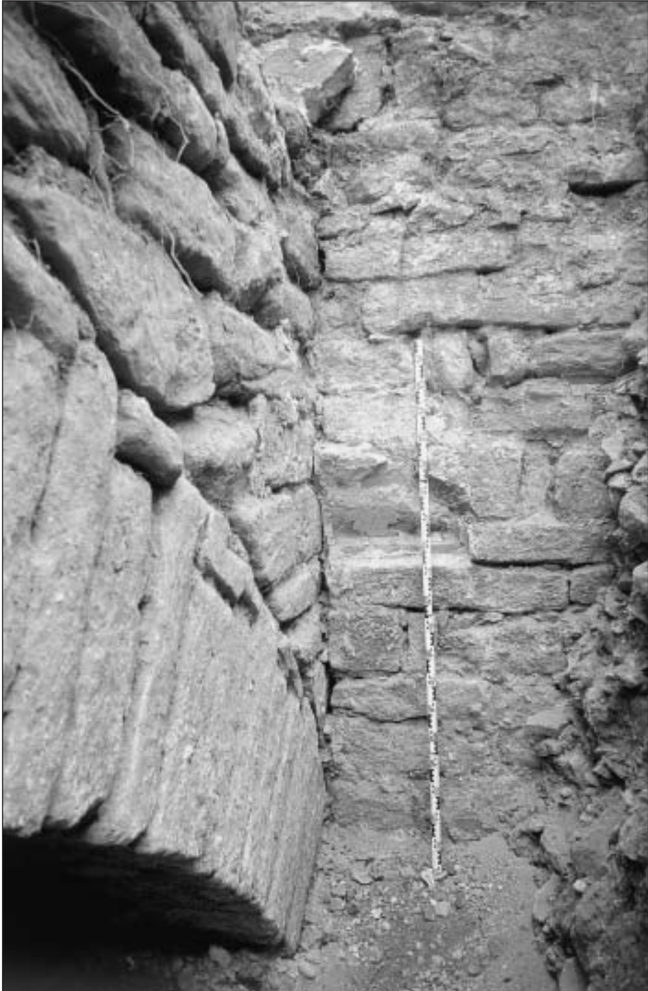
Foto 4. Detalle del encuentro del primer arco oriental del puente con la muralla occidental de Puente la Reina. La segunda se adosa al primero. Sobre este punto se levanta el Torreón y Portal del Puente, también llamado en la documentación de la Carnicería
