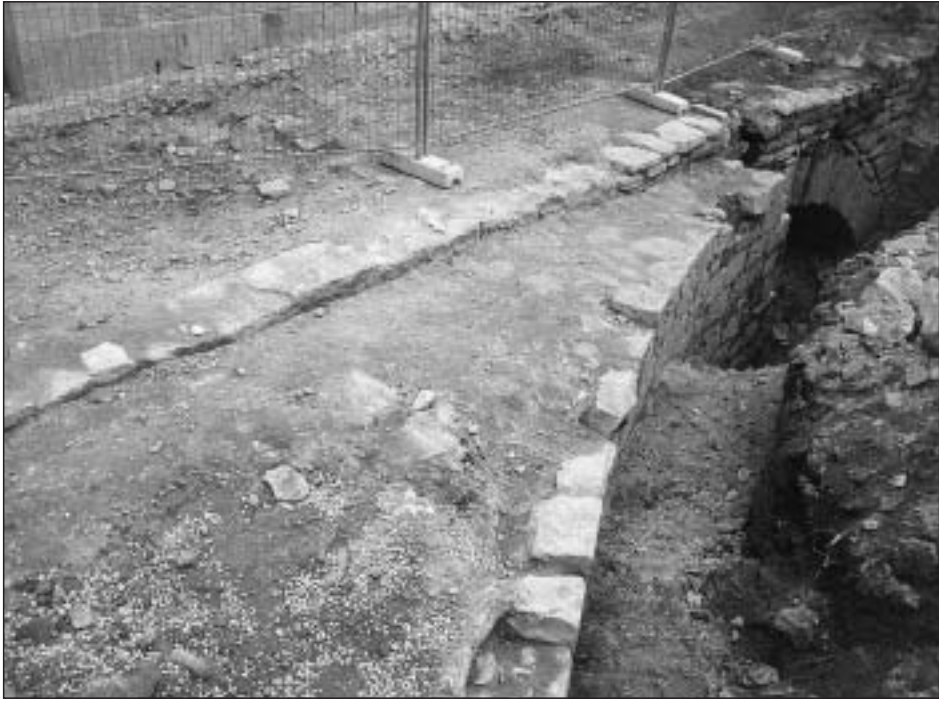
Foto 8. Vista general de la calzada del puente tras la excavación. Obsérvese cómo a la fábrica del puente se le adosa una estructura muraria curva con relleno macizo de piedras para facilitar el acceso al mismo desde la calle La Población como tramo de camino real (siglo xix)
