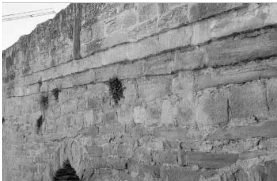
Foto 10. Detalle del ensanche y pretil que sufrió el puente románico en los primeros lustros del siglo XIX
