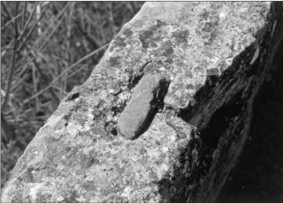
Foto 13. Detalle de la unión de los sillares del pretil mediante rozas laterales y sellado mediante canto y argamasa
