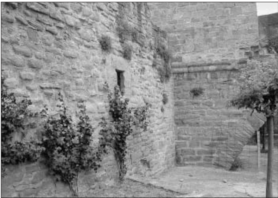
Foto 9. Vista exterior de la intersección a 90° de la muralla occidental de Puente la Reina con la fábrica del puente románico entre su primer y segundo arcos. Obsérvese que en este punto se tapió la ventana-aliviadero del puente para reforzar la cimentación del torreón y evitar la escalada. En la muralla se observa la ventana correspondiente a la bodega de la casa que se levantó hasta el siglo xix en la Placeta del Puente
