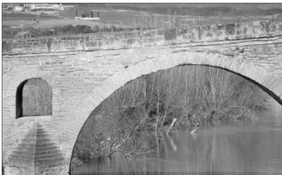
Foto 11. Detalle del tercer arco oriental del puente. Obsérvese que su fábrica diferencial delata una renovación parcial de su estructura tras un derrumbe, que lo interpretamos intencionado a causa de la guerra de la Independencia (hacia 1809)
