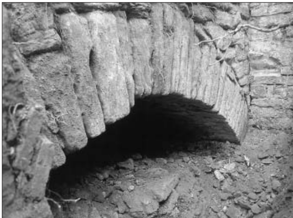
Foto 3. Vista parcial del arco exhumado en los momentos iniciales de la excavación
