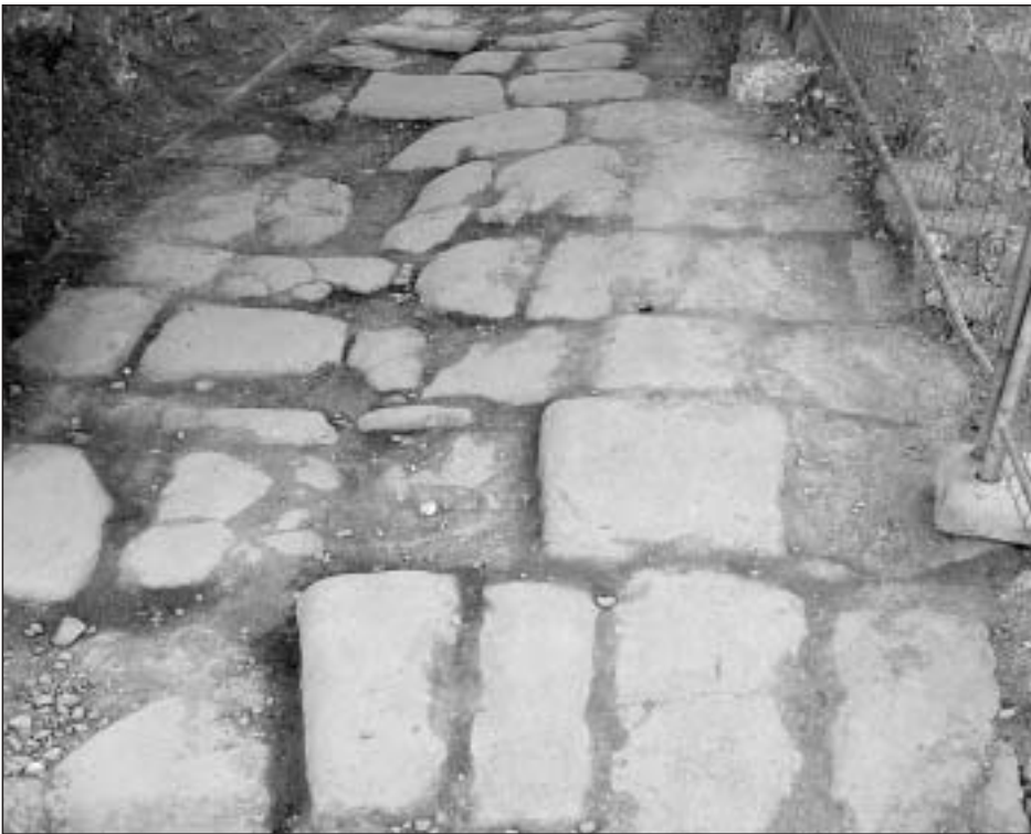
Foto 7. Vista, tras su limpieza, del pavimento original de losas exhumadas en el primer tramo recuperado, a la altura del torreón reconstruido
